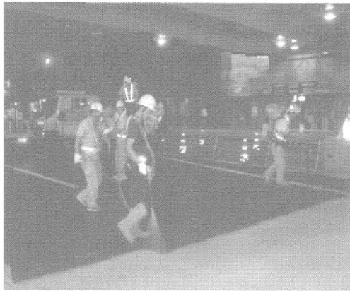
写真-1 遮熱性舗装の施工 1)
