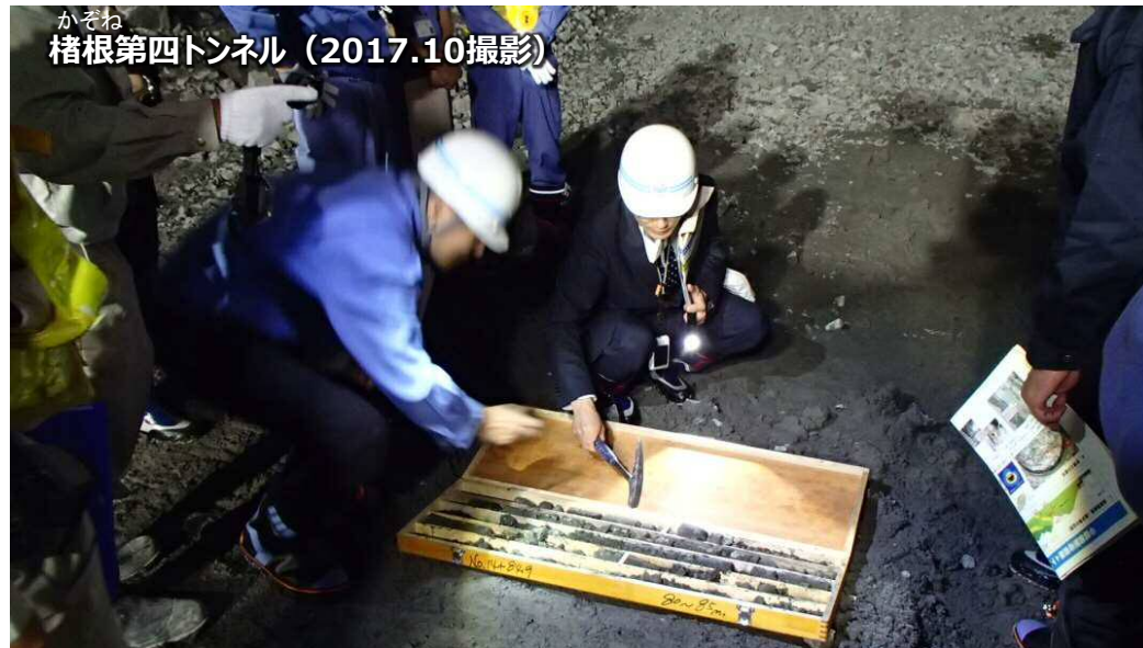
ボーリングコアの確認
