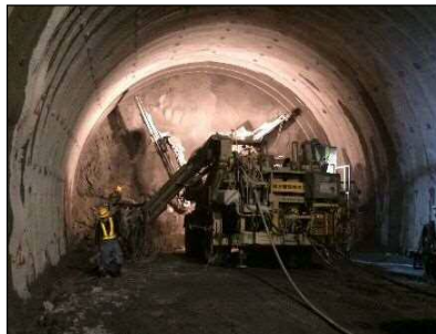
① 樽峠トンネル
