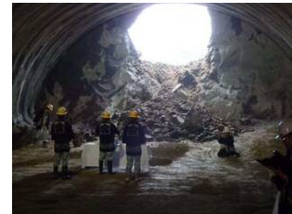
④ 和田トンネル
