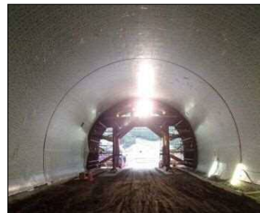
③ 椿根第三トンネル
