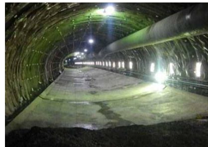
④ 楮根第四トンネル
