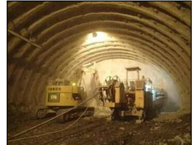
⑤ 上八木沢トンネル ※トンネル・橋梁名称は仮称です。
