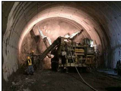
① 樽峠トンネル
