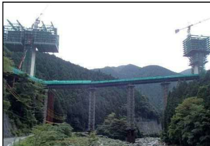
② 富士川第一橋
