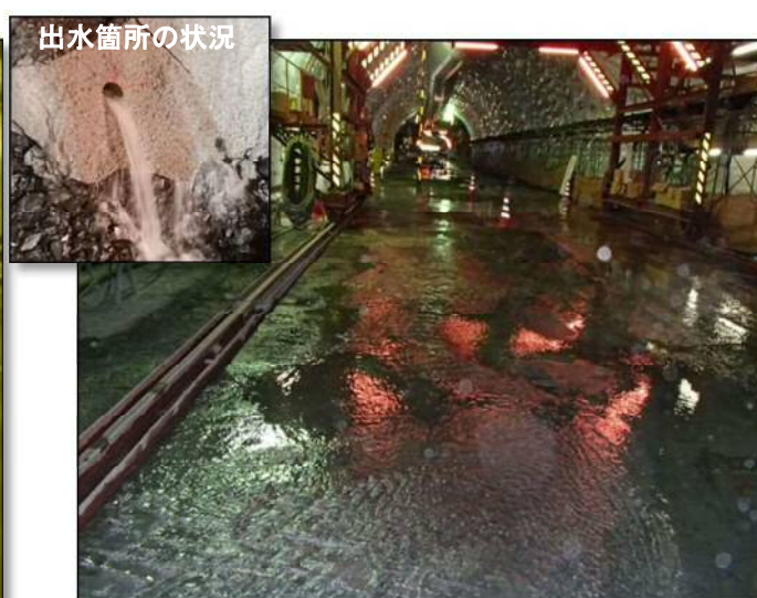
■トンネル坑内の冠水の状況(楮根第4トンネル) かぞね
