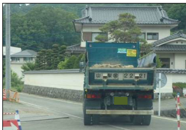
■地域内の道路を利用した掘削土の運搬状況
