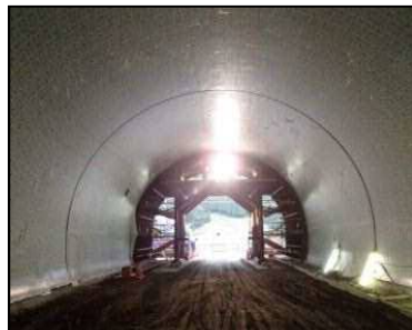
③ 楮根第三トンネル
