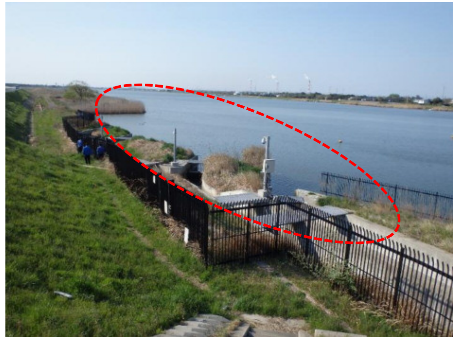
フェンスの設置状況
