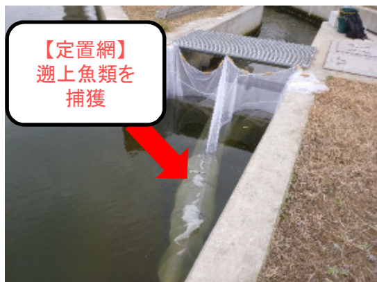
定置網設置状況
