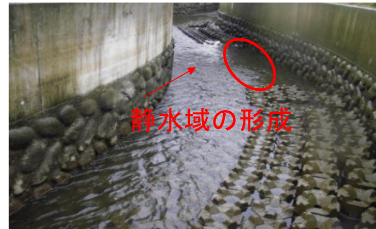
魚道内ブロックの埋め込み状況
