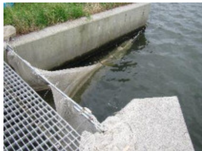
定置網設置状況
