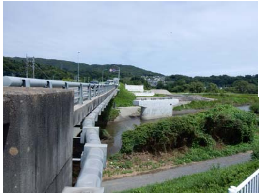
茂宮川橋 H28.8撮影
