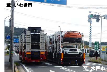
大和田拡幅区間の完成自動車輸送状況
