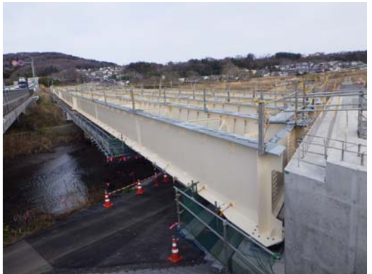
茂宮川橋 H30.3撮影
