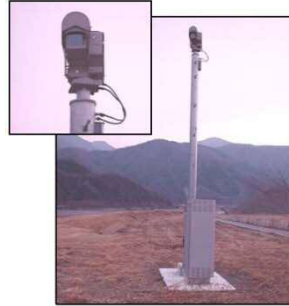
河川監視カメラ
