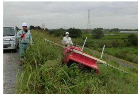
写真-2 植物生長調整剤の散布状況 (関東地方整備局 渡良瀬川河川事務所HPより)
