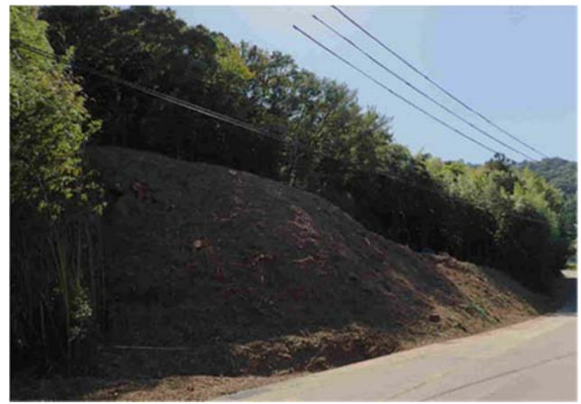
写真-1 現場着手前(伐採後)
