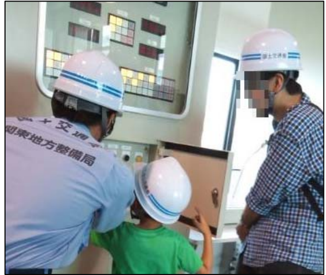
写真-3 水門を閉めるボタンを説明する様子
