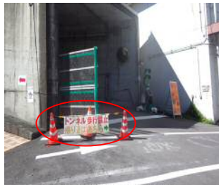
図-10 注意喚起表示の状況
