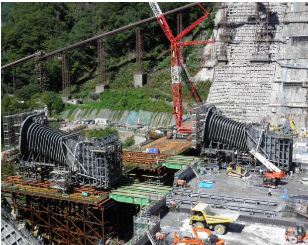
図-6-2 1号放流管引込完了後、2号放流管引込前
