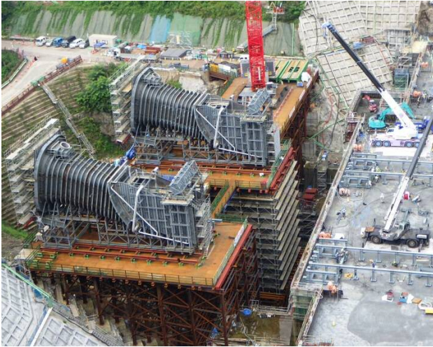
図-6-1 放流管組み立て完了（外部足場撤去後）
