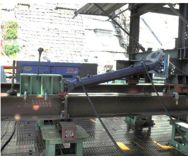
図-6-3 放流管引込用油圧ジャッキ
