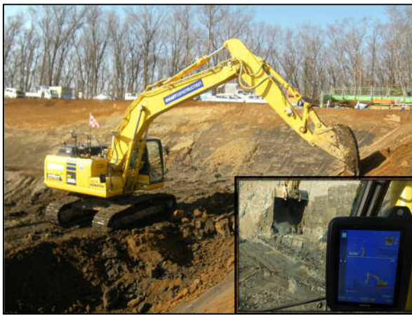
写真-2 MCバックホウによる施工
