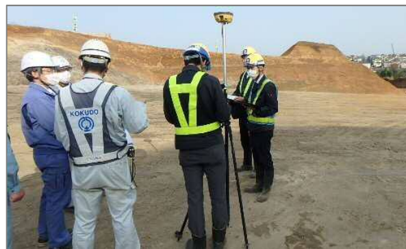
写真-3 GNSSローバーを用いた測量
