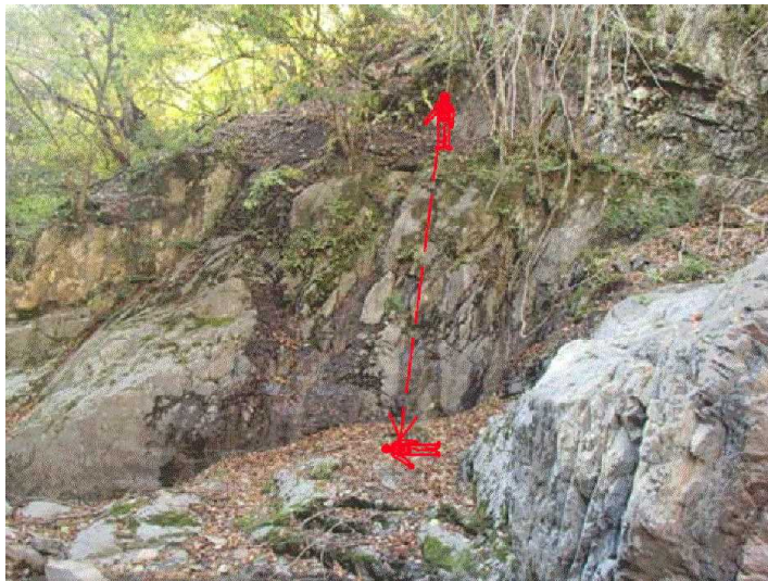
測量作業中に7m転落し骨折した事例
