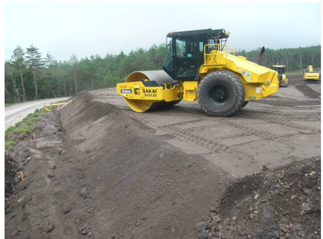
図-8 ICT建機による盛土の転圧
