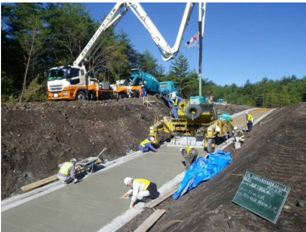
図-4 新技術を用いたコンクリート舗装施工
