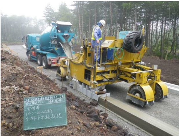
図-3 新技術を用いたL型側溝施工
