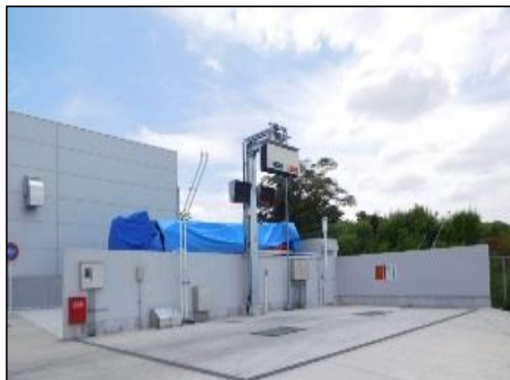
図-3 自家用給油施設
