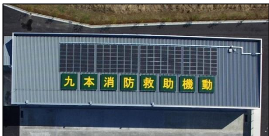
図-6 太陽光発電設備・ヘリサイン
