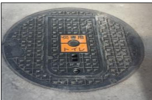
図-5 災害用トイレ
