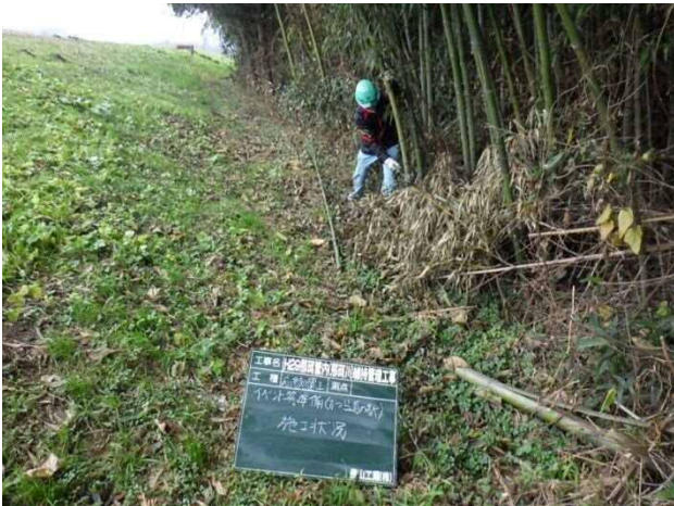
写真-3 竹林伐採 (那珂川左岸 40.0k 高水敷)
