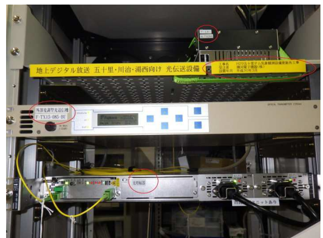
図-4 機器への名称付け事例
