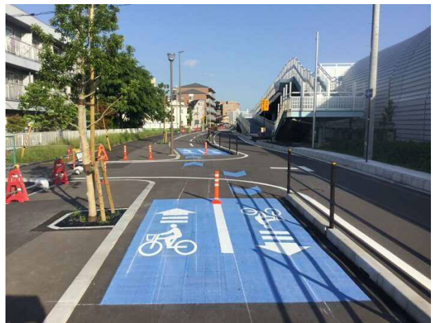
写真-2 細街路交差点部安全対策
