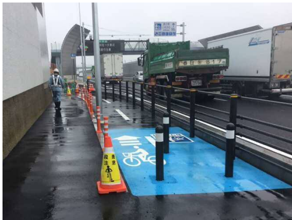
写真-4 要望箇所応急対策
