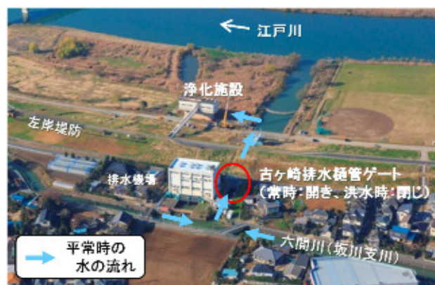
写真-1 古ヶ崎排水樋管の役割
