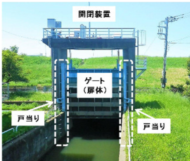
写真-2 ゲート設備の構成
