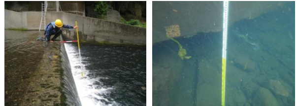
図-13 水中の洗掘状況の確認
