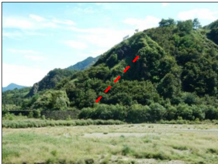
図-17 レーザースキャナによる測量箇所
