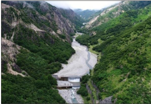
図-10 松木川五号砂防堰堤 全景
