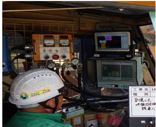
図-11 施工管理写真
