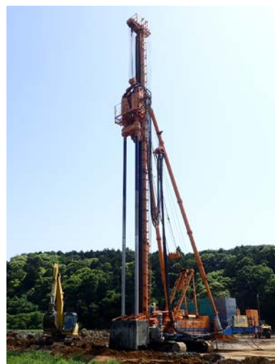
図-8 深層混合処理 施工機械
