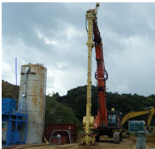
図-6 機械攪拌工法 施工機械
