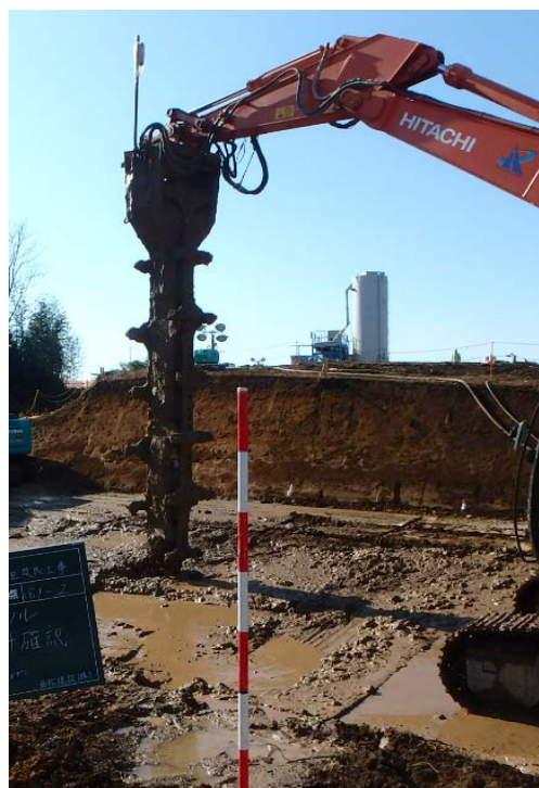
図-7 機械攪拌+噴射工法 施工機械
