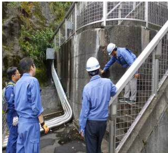
【写真-2】フーチング階段職員点検
