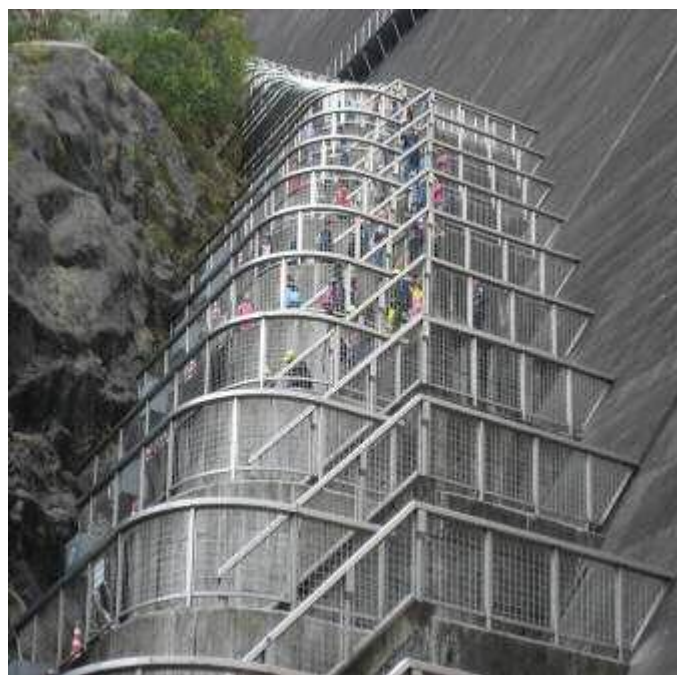
【写真-3】フーチング階段開放時
