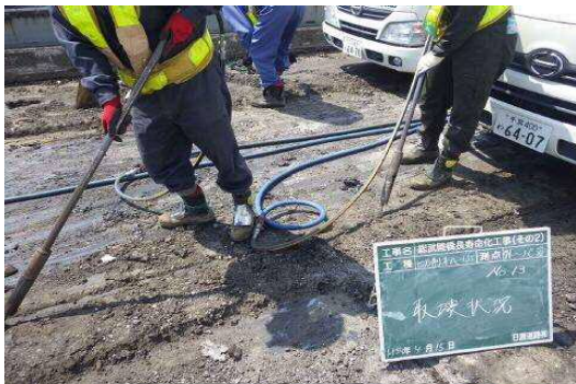
写真-6 添接部の手はつり状況
