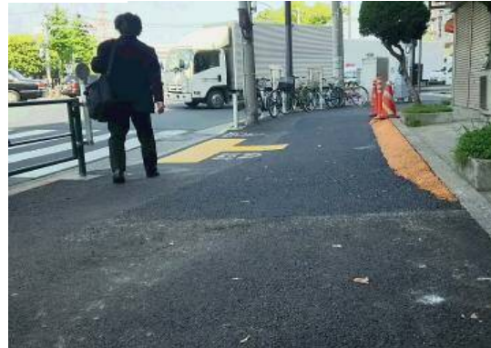
写真-4 暫定案工事後
