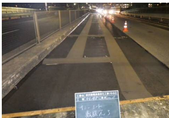
写真-9 クラック防止シートの施工後
