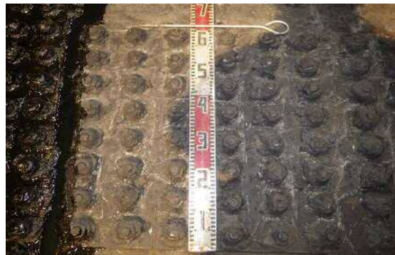
写真-7 添接部の手はつり完了後
