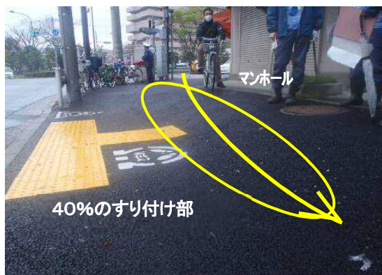
写真-2 40%のすり付け勾配の歩道
