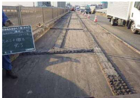
写真-8 添接部の基層アスファルトを残した状況
