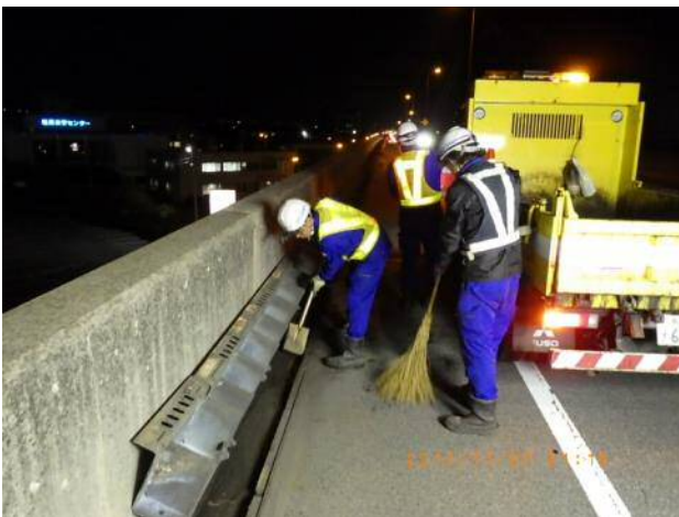
写-8 現地状況 (排水清掃中)
