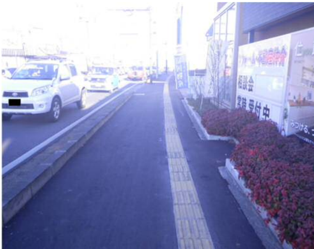
写－6 現地状況（舗装復旧完了）
