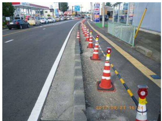
写-5 現地状況（植樹帯撤去完了）
