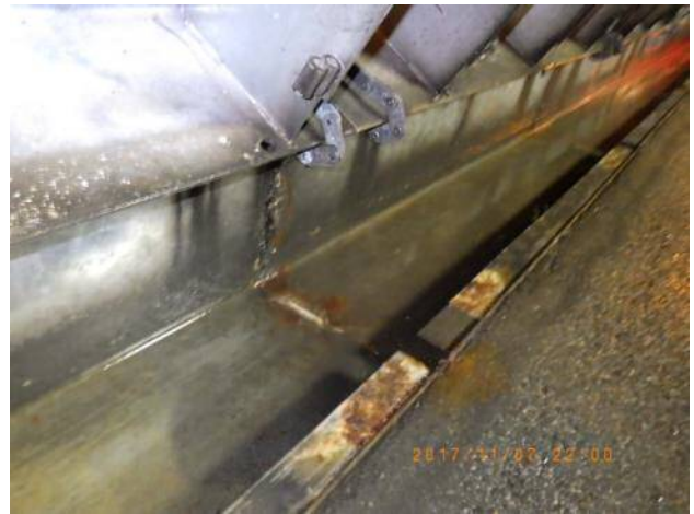
写-9 現地状況 (排水清掃完了)
