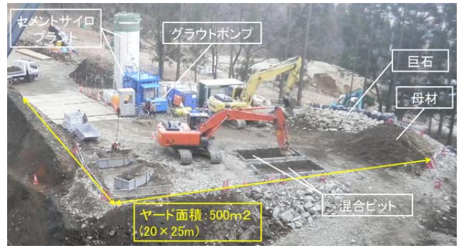
写真-2 施工ヤード
