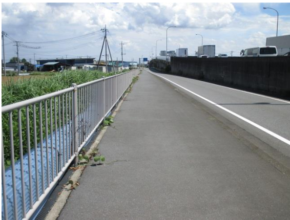
写真－1 2 6月中旬における歩道部の状況
