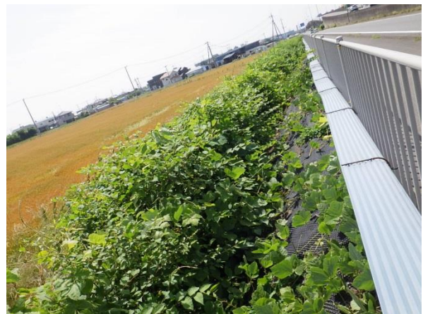
写真-9 5月中旬における法面部の状況
