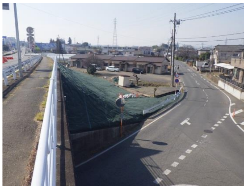
写真-3 防草シート設置状況
