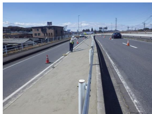
写真-5 防草コンクリート施工状況
