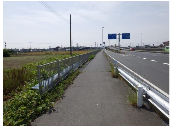
写真-8 5月中旬における歩道部の状況
