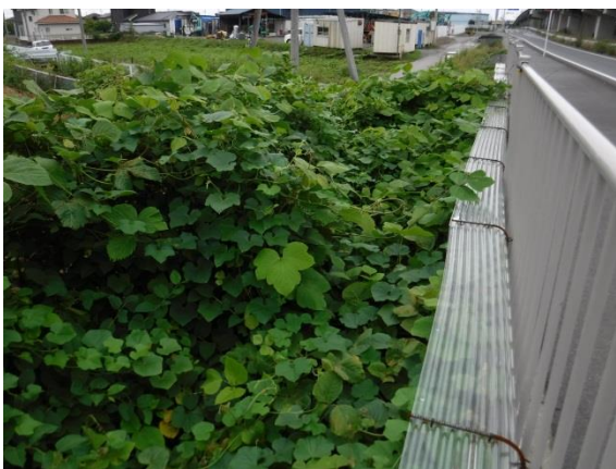
写真－1 3 6月中旬における法面部の状況
