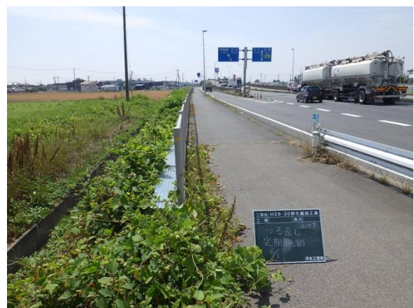
写真-10 6月上旬における歩道部の状況
