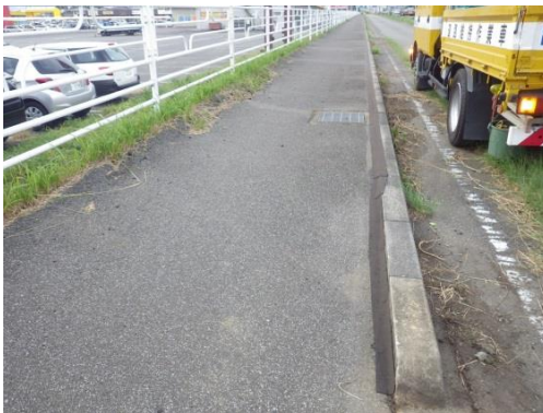
写真-4 防草テープ施工状況
