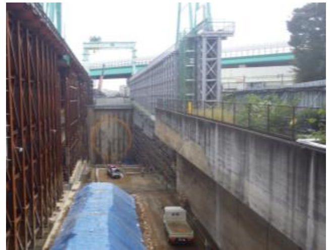
図-9 トンネル径がペイントされた現場風景
