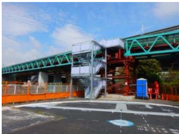
図-6 傾斜が緩やかで踊り場の設置された現場階段
