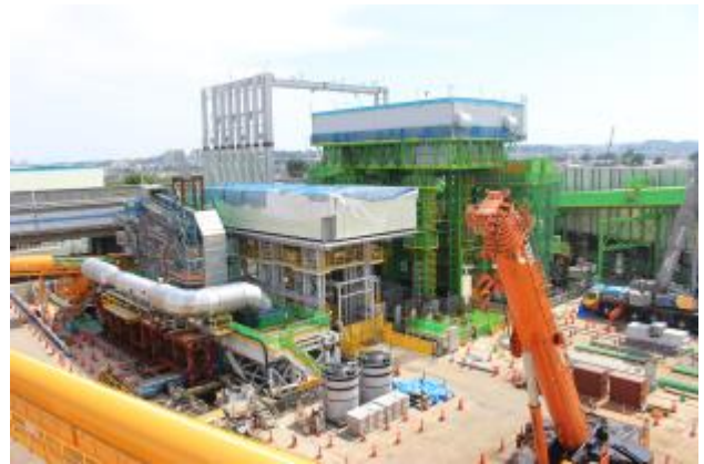
図-2 東名JCTの現場写真
