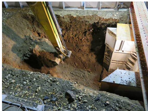
写真－5 掘削状況
