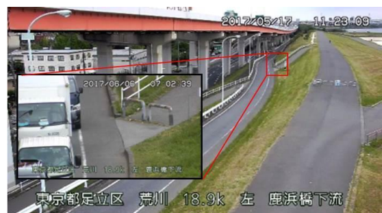
図-3 CCTV映像(川裏側旋回)
