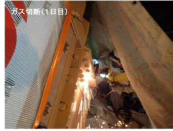
写真-11 ガス切断写真
