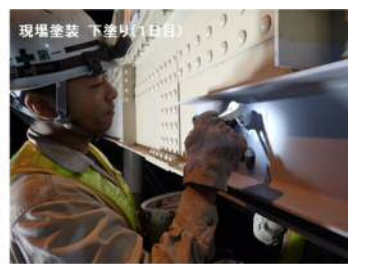
写真-16 ボルト本締め・現場塗装(下塗り)写真
