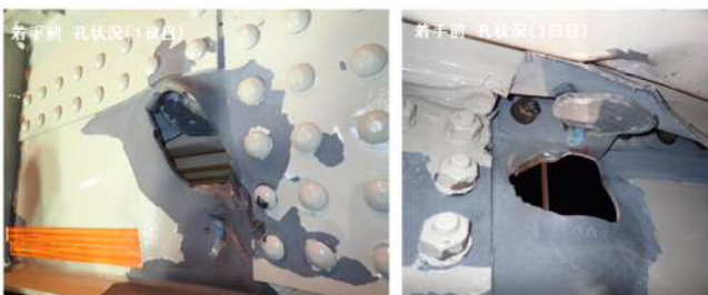
写真-10 着手前写真
