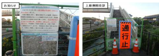
写真-9 階段部お知らせ貼付状況
