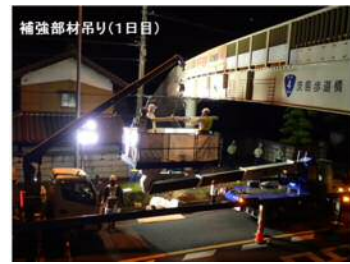
写真-14 補強部材取付写真
