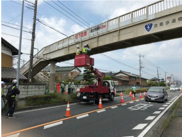
写真-5 近接詳細点検
