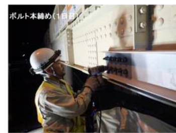
写真-16 ボルト本締め・現場塗装(下塗り)写真
