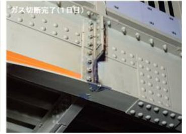
写真-11 ガス切断写真
