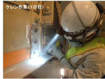
写真-12 素地調整写真
