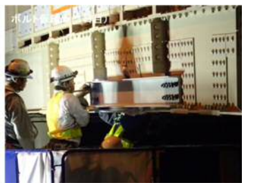
写真-15 補強部材取付・ボルト仮締め写真
