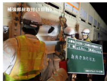
写真-15 補強部材取付・ボルト仮締め写真
