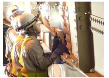
写真-14 補強部材取付写真
