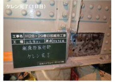
写真-12 素地調整写真
