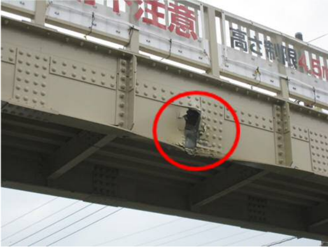
写真-1 ウェブ側面に穴と歪み
