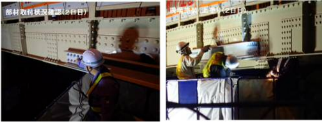
写真-16 部材取付状況確認・現場塗装(上塗り)写真
