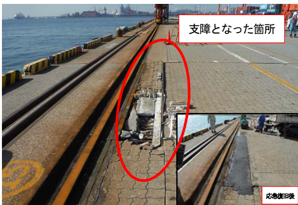
写真-3 支障箇所及び応急復旧後
