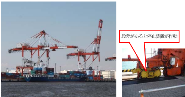
写真-2 ガントリークレーン
