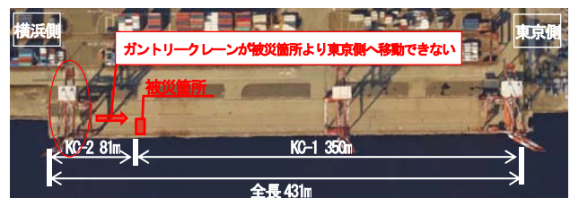
図-14 被災箇所とガントリークレーン位置関係
