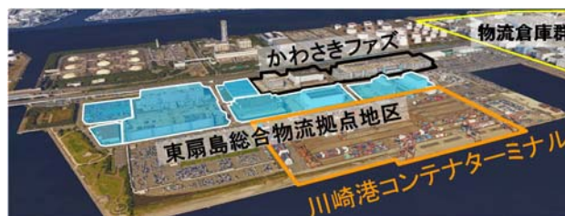
図-3 川崎港コンテナターミナル周辺状況
