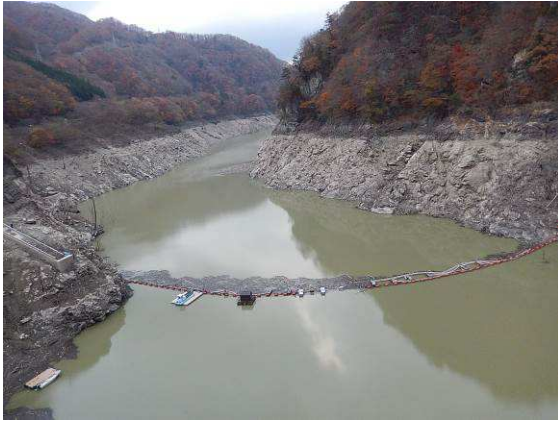
工事制限水位時の貯水池の状況
