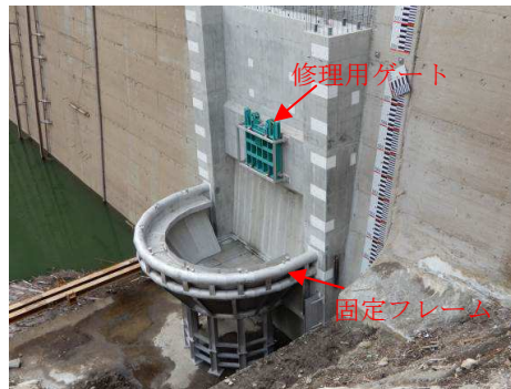
貯留開始前の状況
