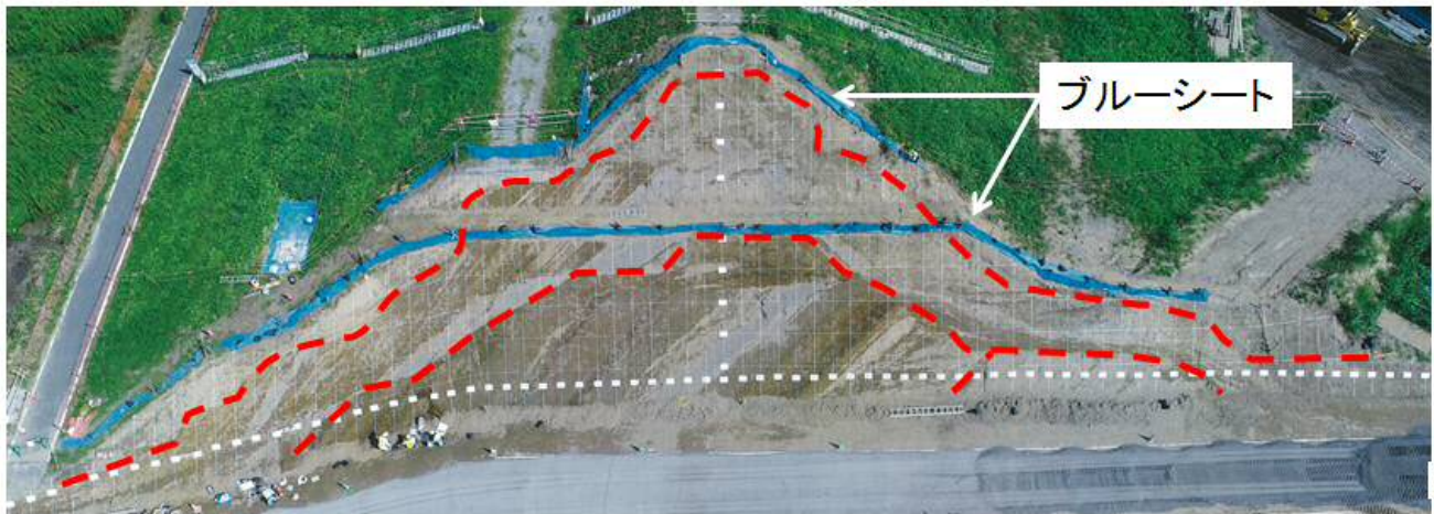
写真-2 堤防開削断面写真（下流側）
