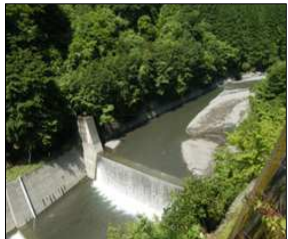
写真-1 貯砂ダム
