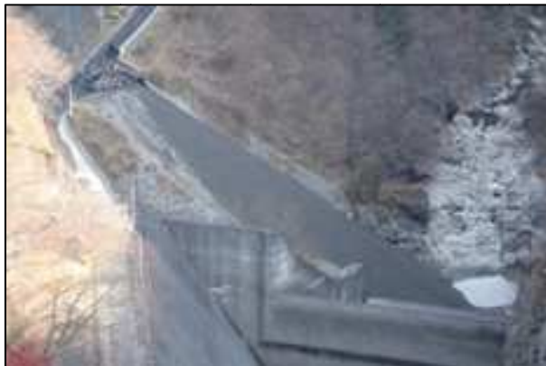
写真-3 副ダムの置き土
