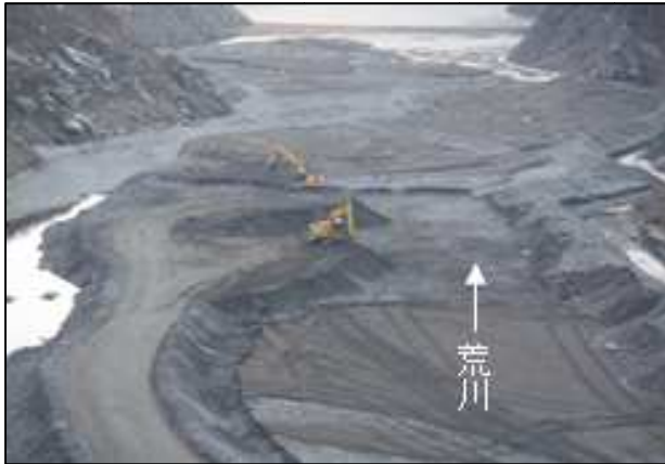
写真-2 貯水池内での掘削
