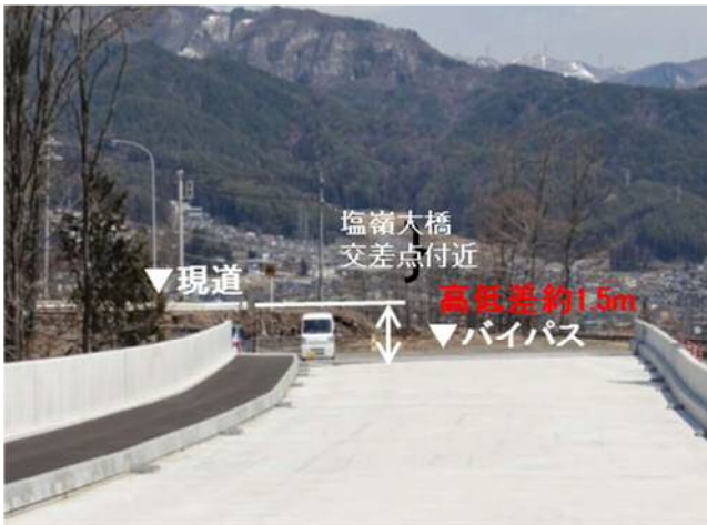
写真-3 改良工事前の塩嶺大橋交差点付近の状況
