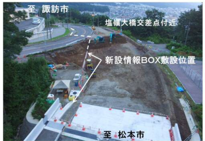
写真-5 バイパス側の情報BOX敷設位置
