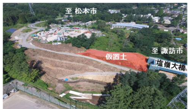
写真-1 仮置土の現場状況
