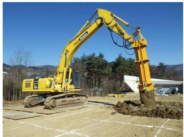
写真-2 WILL工法の施工状況
