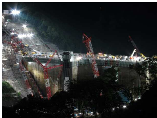
図-7 夜間のハッ場ダム本体工事現場
