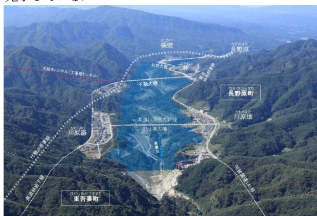
図-2 ダムサイトから見た生活再建事業の状況
