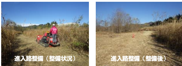
図-5 進入路整備状況と整備後の様子
