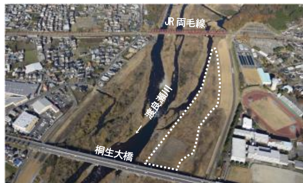
図-1 渡良瀬川左岸50.6K付近（群馬県桐生市）の状況
