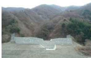
不透過型砂防堰堤(早川町 木挽崩沢砂防堰堤 平成20年3月完成)
