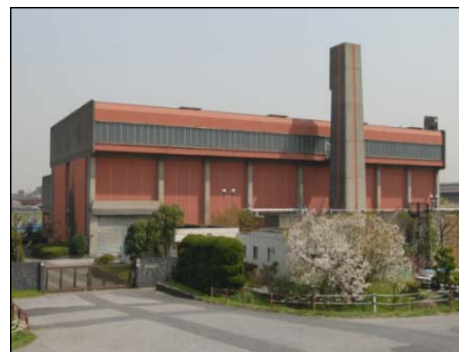
新芝川排水機場
