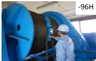
機械設備動作確認(岩淵水門)
