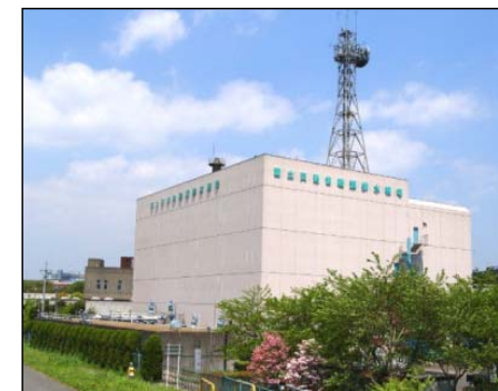
綾瀬排水機場
