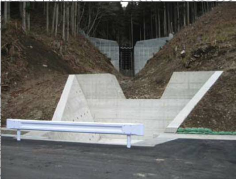
ウドン沢砂防堰堤
