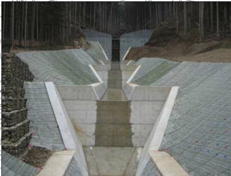
中坪上沢砂防堰堤
