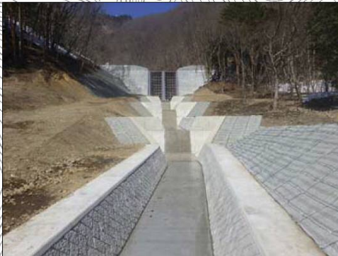
下坪沢砂防堰堤
