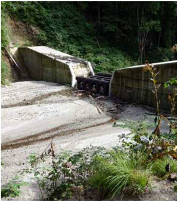
田茂沢第1砂防堰堤（左：土石流発生前 右：土石流発生後）
