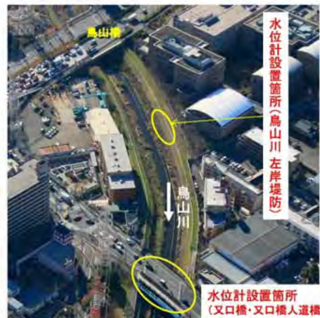
水位計設置箇所
