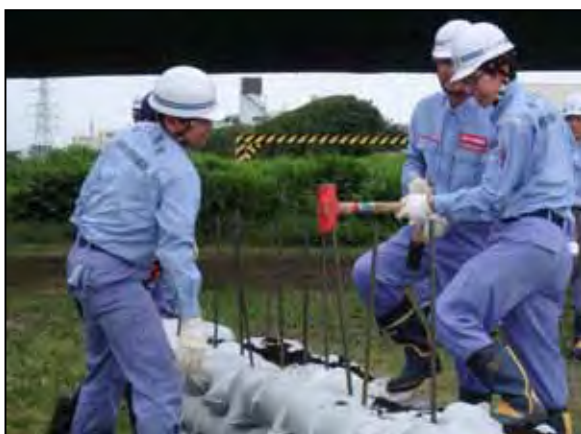
積み土のう工
