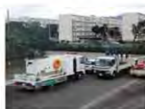
富士市五貫島(元富士樋管)での排水作業 ～建設業者による対応～
