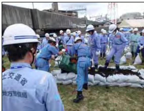
積み土のう工
