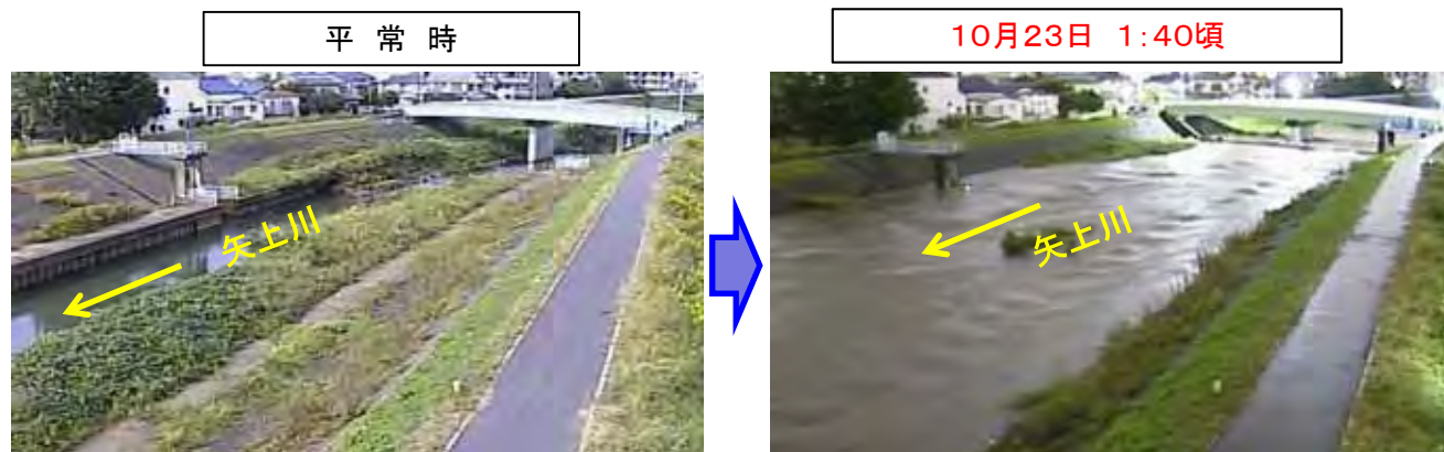
矢上川:左岸 1.4km付近 矢上橋 (川崎市幸区南加瀬地先)
