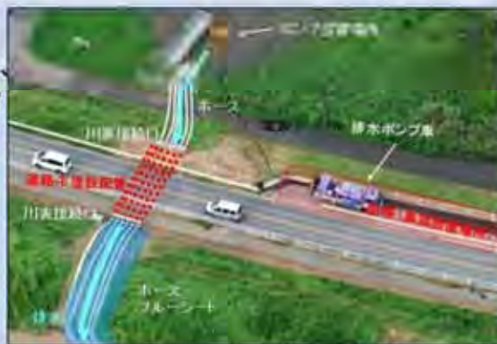
道路下配管及び側帯
