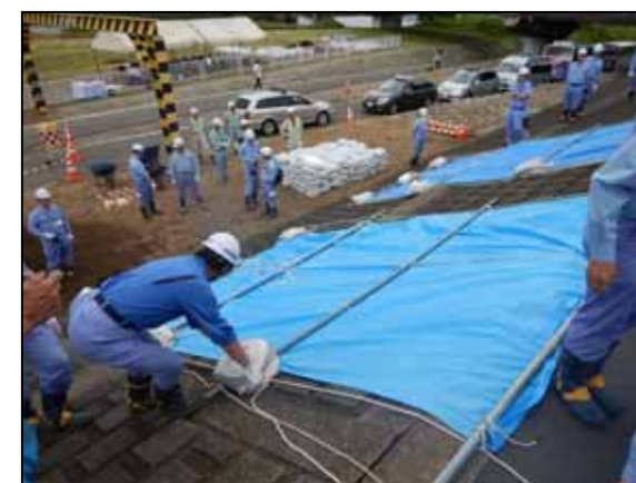
シート張り工
