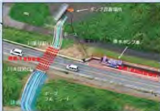
道路下配管及び側帯
