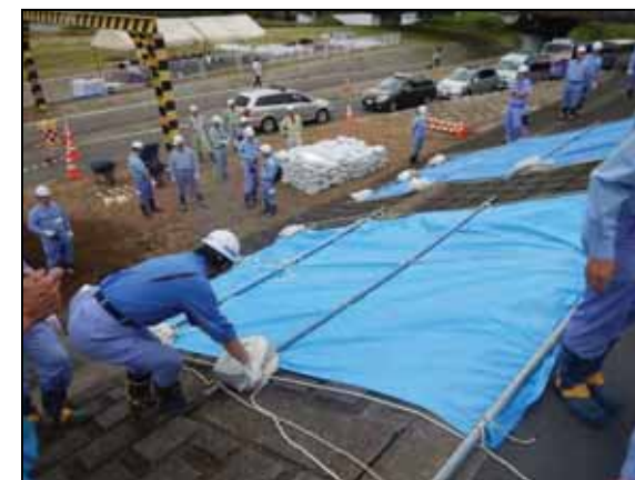
シート張り工
