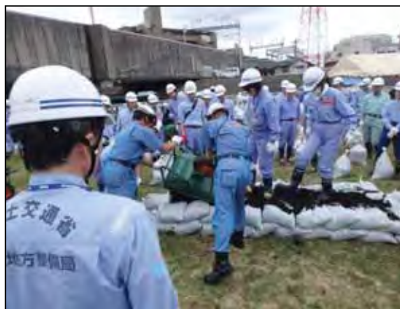
積み土のう工
