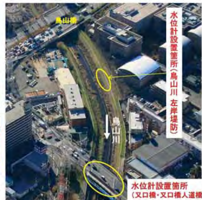
水位計設置箇所
