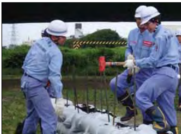
積み土のう工
