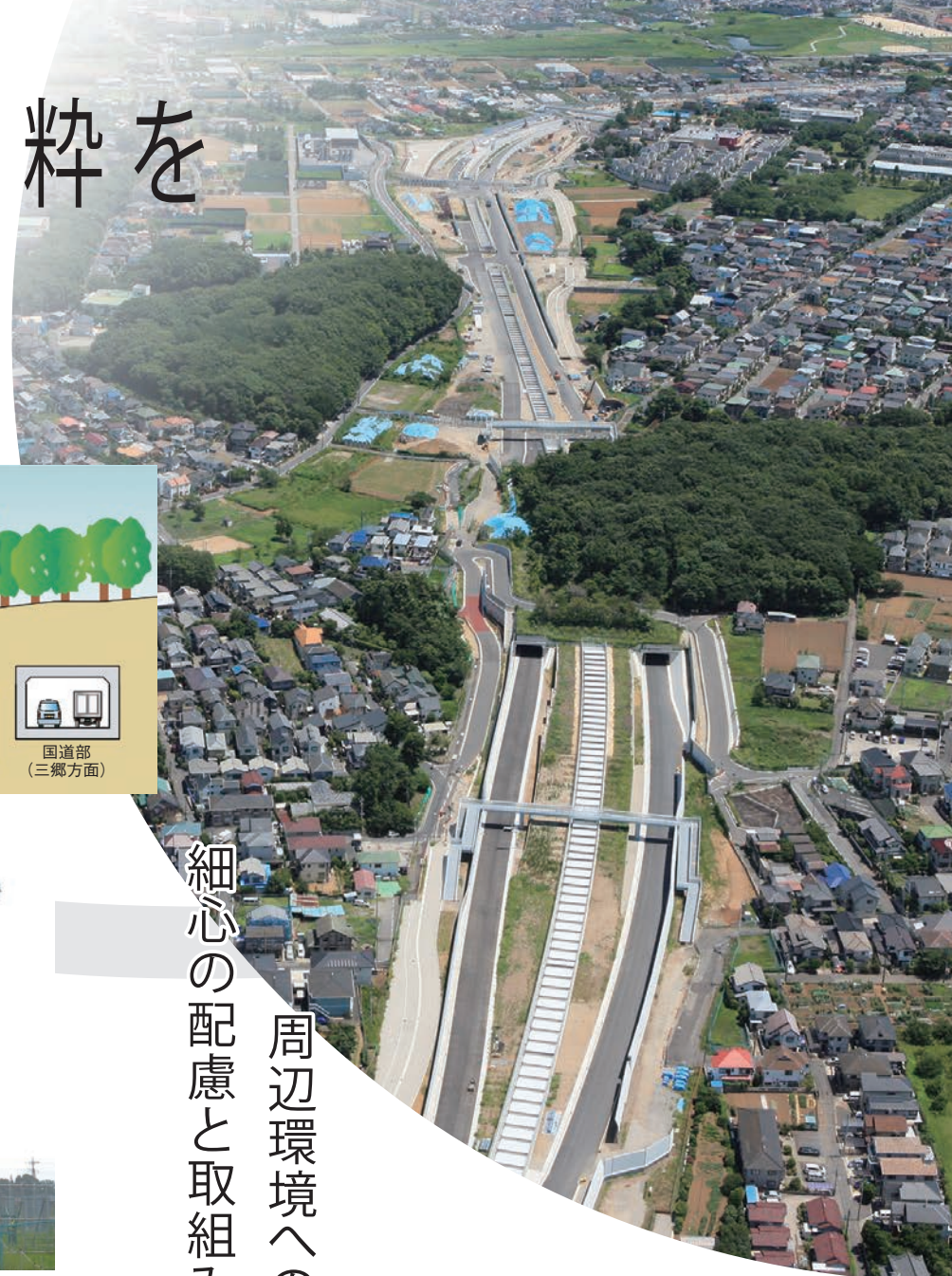
小塚山周辺工事の様子
