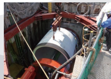
市川南7号幹線工事の様子
