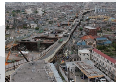
工事車両専用仮橋
