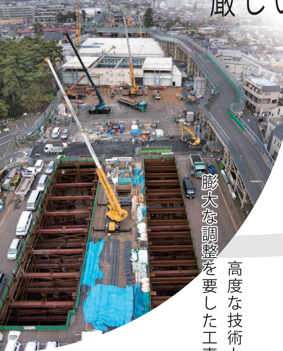
国道298号工事の様子
