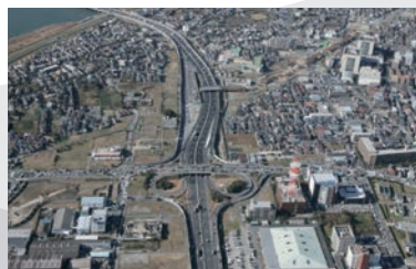
京葉JCT切り回し工事の様子
