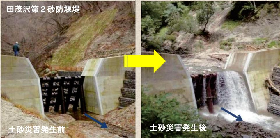
関東・東北豪雨では、芹沢地区上流の田茂沢第1砂防堰堤、田茂沢第2砂防堰堤が下流の集落への被害を未然に防止したほか、芹沢川を中心に設置された6基の砂防施設も土砂や流木を捕捉し、効果を発揮しました。
