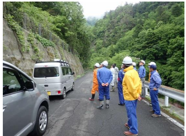
法面状況調査
