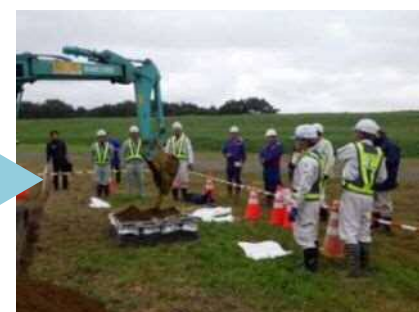
②土砂投入
