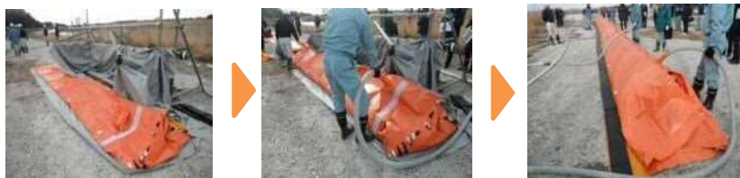
水の注入により『水嚢』が大きくなる様子
