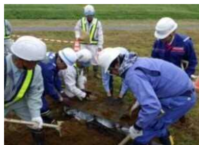
③土砂詰め込み～敷均し
