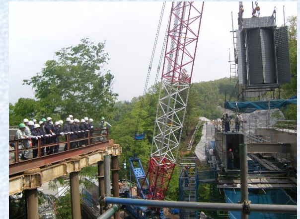
鋼橋の架設工法見学
