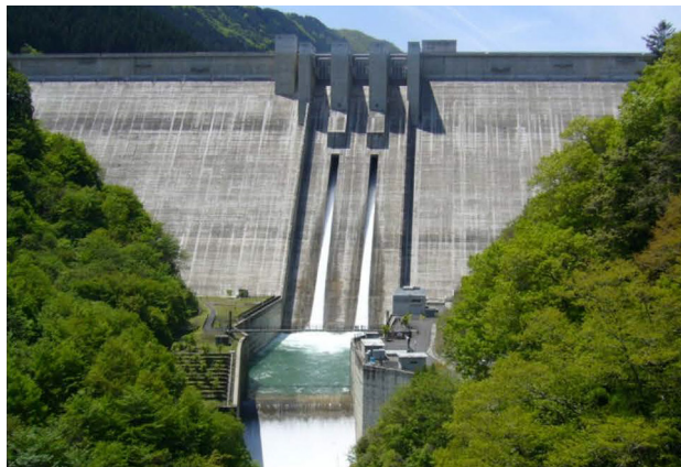
堤体を下流より望む
