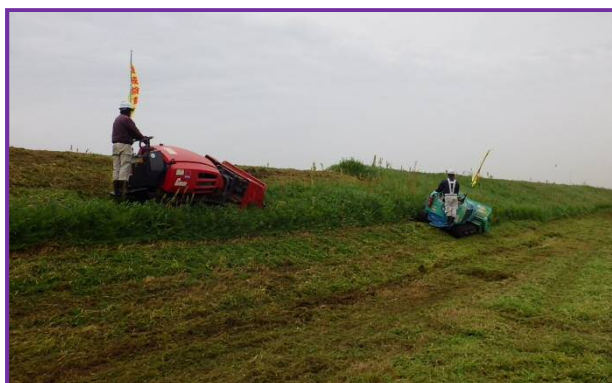
堤防除草作業の状況
